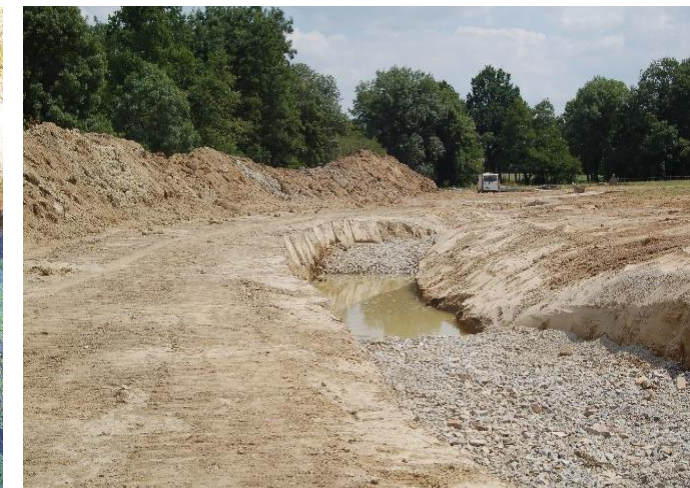
Aménagement du tronçon remis en talweg sur l'Ise au Moulin de Mesneuf avant sa mise en eau en juillet 2018 (à gauche). Alternance de faciès lotiques végétalisés et de plats lents sur le secteur d'inventaire du tronçon en juillet 2019 (à droite)
