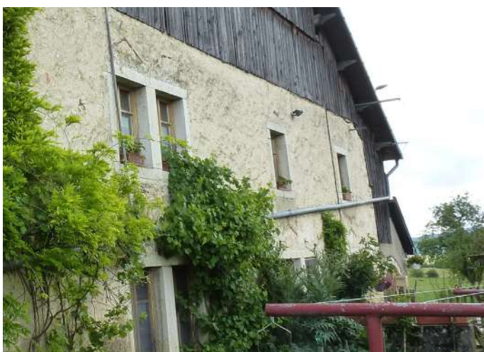
Exemple d'aménagement de gouttières pour récupérer le pan de toit opposé
