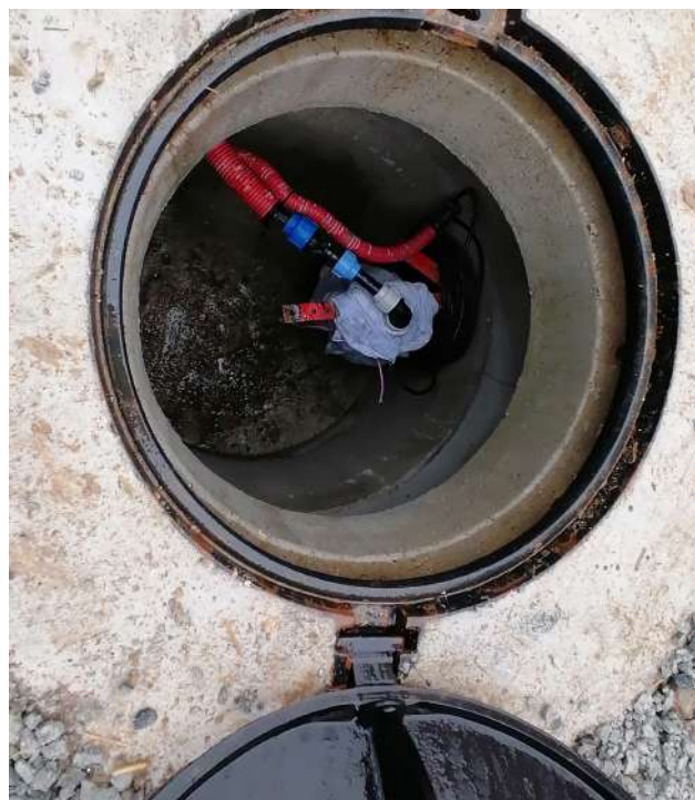
Regard de forage
