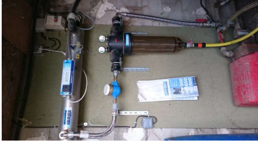
Exemple d'installation de traitement de l'eau avec lampe UV chez un éleveur de Haute Saône (BFC)
