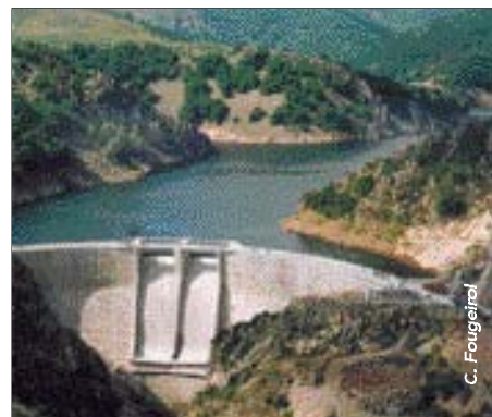
La retenue de Puylaurent sur le Chassezac (Lozère) est un exemple où quatre fonctions sont assurées : soutien d'étiage et irrigation en été ; production hydroélectrique en hiver et au printemps ; stockage des crues au printemps et en automne.
