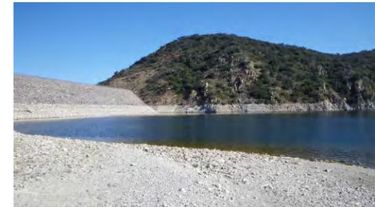
*Fort marnage empêchant l'installation d'un écosystème littoral sur la retenue de Caramany*
