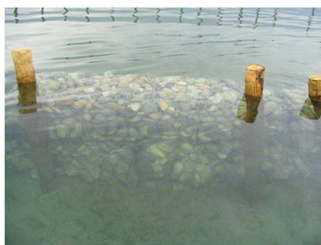
Gabions implantés sur le lac du Bourget (CPNS)
