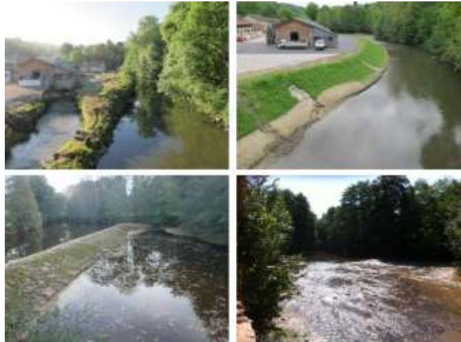
Figure 13 : Suppression du seuil de la cristallerie de Saint Paul sur la Briance (source : site de l'Agence de l'Eau Loire-Bretagne)
