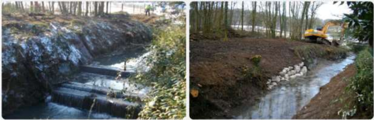
Figure 14 : Suppression d'un seuil sur la Remberge à Saint-Ouen-les-Vignes (37)
