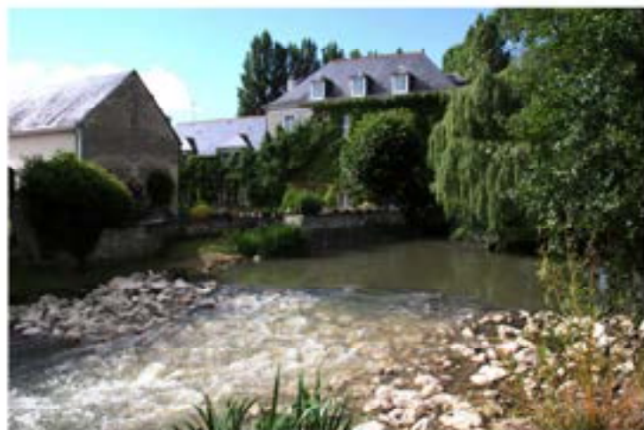
Travaux d'arasement partiel - Indre et Loire (37)
