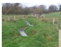
Photo n+3 travaux (72)
