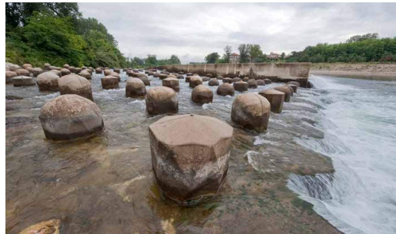
Passe à poissons dans les gorges du Gardon © Terra / L. Mignaux
