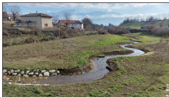
Figure 1. Reméandrage de l'Olon (Isère) afin de lui donner un fonctionnement plus naturel tout en ralentissant sa vitesse et l'impact des inondations sur la voie ferrée
