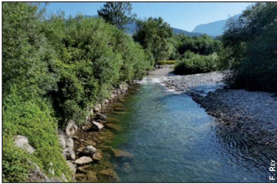
Figure 2. Les SFN peuvent permettre de restaurer une biodiversité tout en protégeant les biens et les personnes contre les inondations. Sur le Guiers (Savoie), des caissons en bois ont été végétalisés, la végétation masquant de plus en plus l'ouvrage dans le temps
