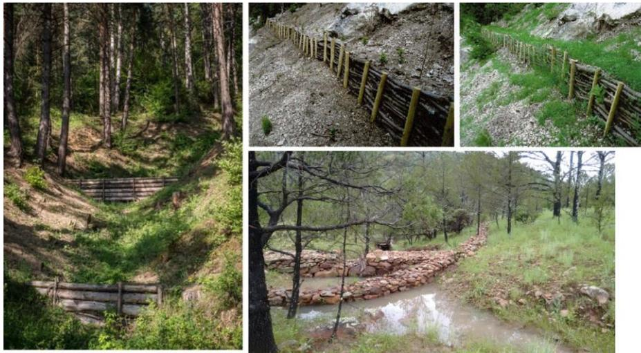
Figure 8 - Photographies de checkdams en bois et en pierre installés dans les talwegs, et d'une fascine végétalisée dans un versant (en haut à droite) (source des images : © Permalab)
